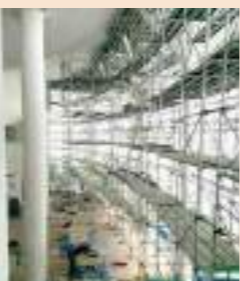
天井改修工事
