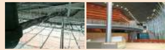
天井改修工事
